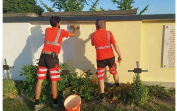
Bauhofmitarbeiter beim Verputzen der Friedhofsmauer
