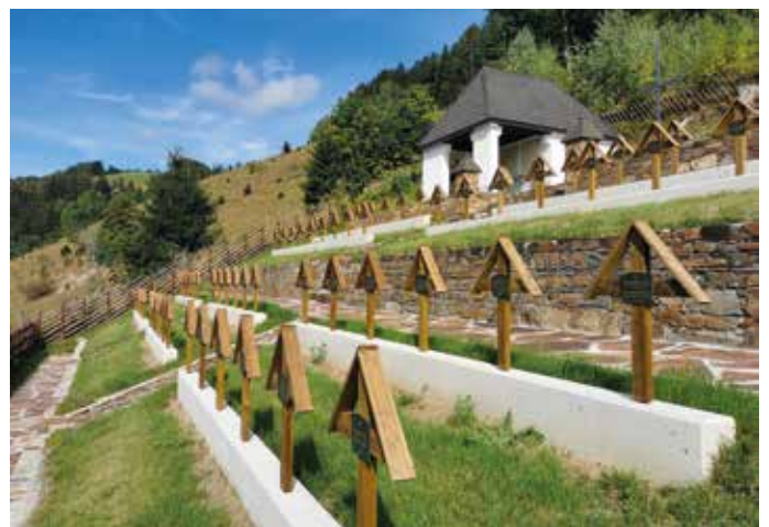
Die neu fundamentierte Grabkreuze, sanierten Gehwege und der „Bandlzaun“
