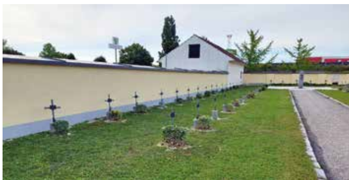
Die sanierte Friedhofsmauer mit neuer Blechabdeckung
