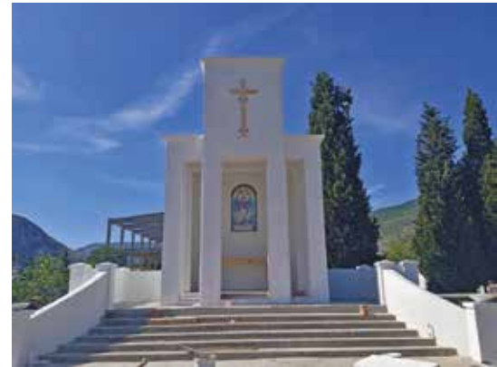
Kapelle nach der Renovierung
